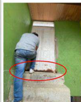
Foto 10 manchas en las juntas del enchape de puerta
