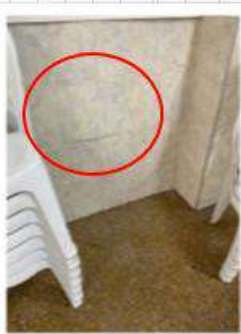
Foto 2 levantamiento del enchape.
