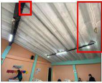
Foto 2 Fisuras en cubierta y manchas de humedad
