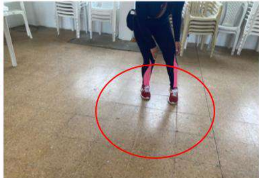
Foto 6. levantamiento de enchape
