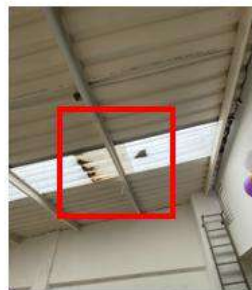
Foto 4 manchas oscuras, quemaduras o degradación del
