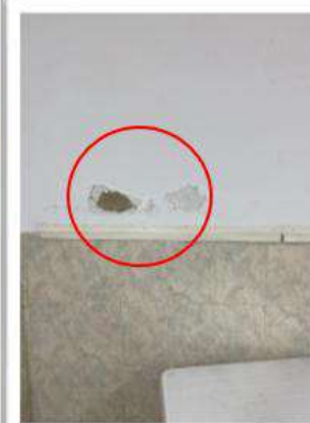
Foto 6 humedad en muro
