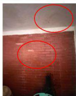
Foto 2 manchas de humedad en techo y muro
