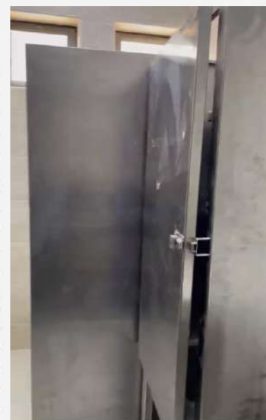
Instalaron divisiones de baño metálicas
