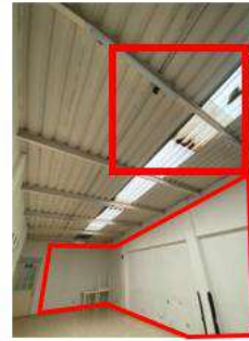
Foto 5 y 6 Estado de deterioro de la cubierta plastica traslucida en el segundo nivel por oxidación
