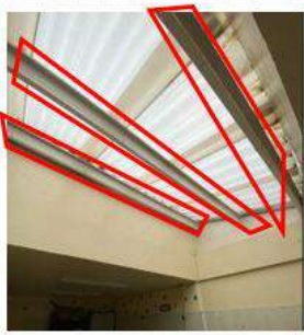
Foto 2 se recomienda verificar: Puntos de anclaje Estado de la pintura anticorrosiva
