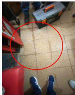
Foto 3 manchas en las juntas del enchape de piso
