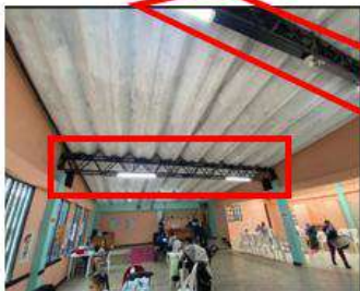
Foto 3 Punto de corrosion en la estructura metalica de la cubierta
